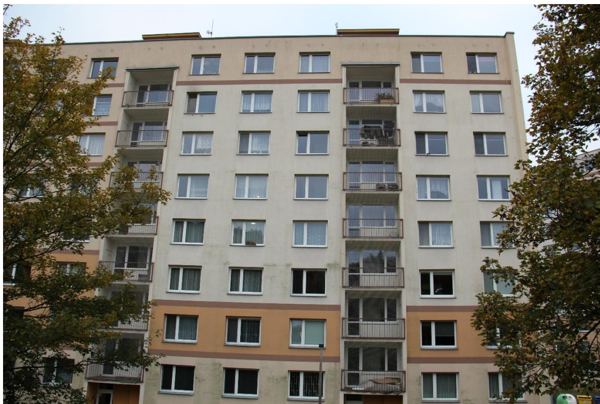
Pohled na posuzovaný bytový objekt Jizerská 1, 3 – zadní průčelí
